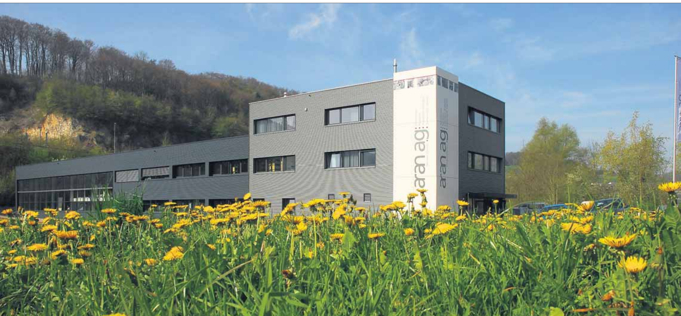
GUT ZU SEHEN Der vorgelagerte Verwaltungstrakt in Massivbauweise und die angrenzende Stahlkonstruktion der Fabrikationshalle HZH
