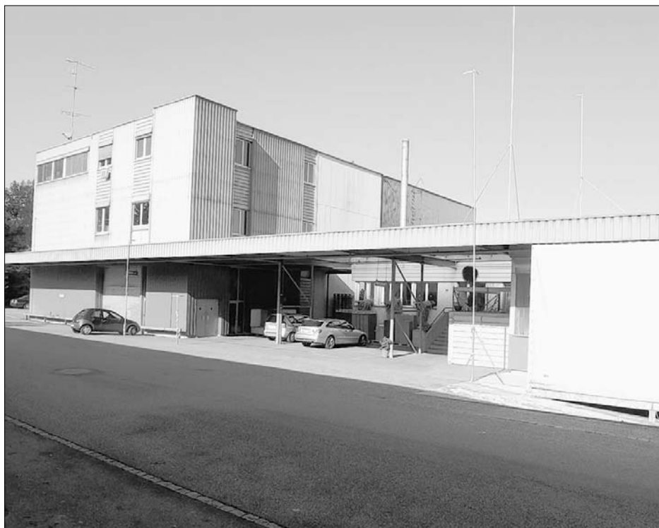
VORHER Die Stöcklin AG in Aesch hat dringend mehr Platz gebraucht.
